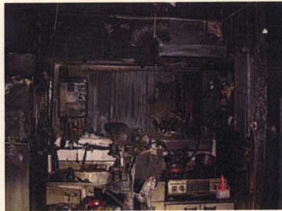
古江台22棟407号室火災 No.370
