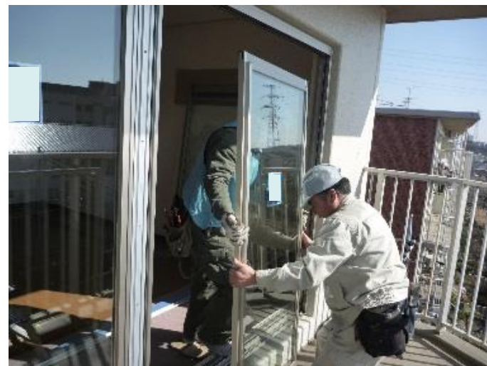
枠カバー工法によるサッシの更新
