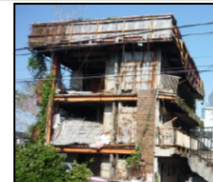
行政代執行により 除却したマンション
