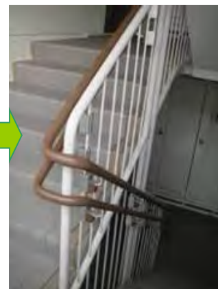
階段手摺の改良（補助手摺追加、2段手摺への更新）
