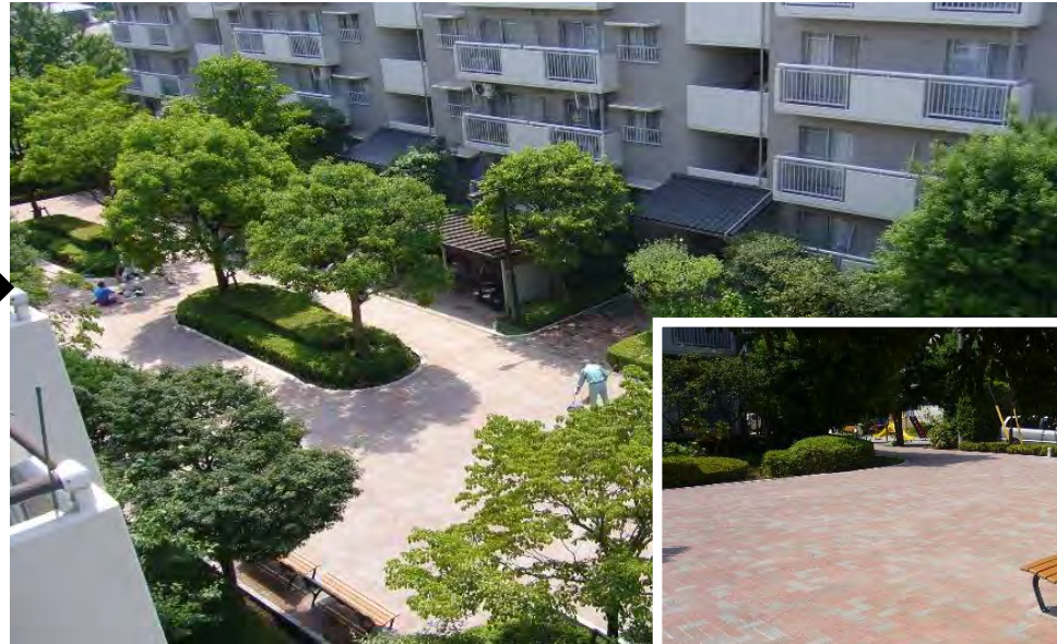
インターロッキングブロック舗装による改修
