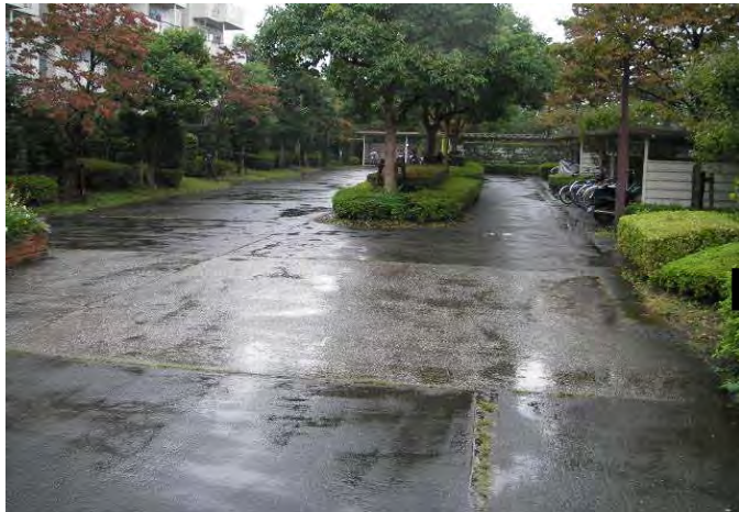
改修前のコンクリート舗装
