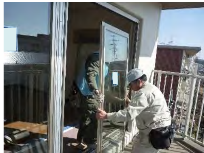
枠カバー工法によるサッシの更新
