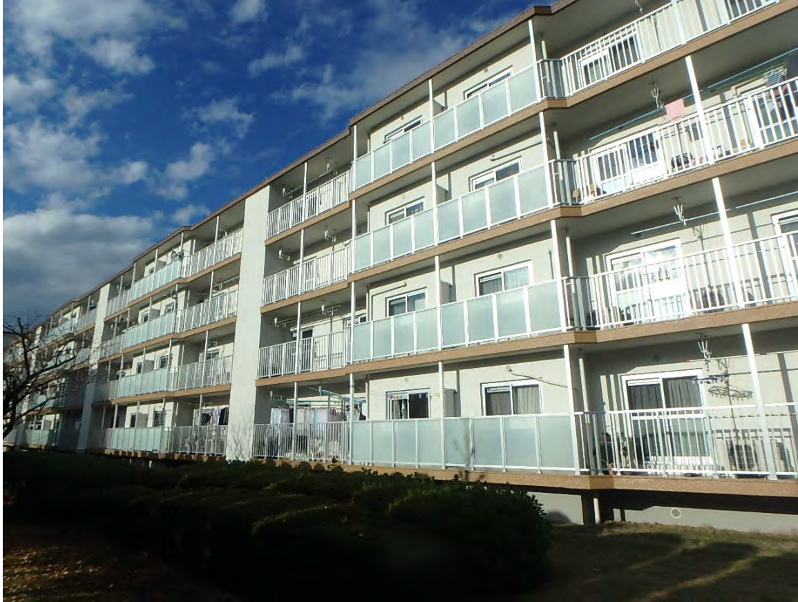
新規アルミ手すり金物（全体外観）
