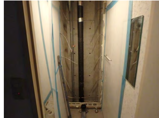
排水管取替えのための室内壁解体
