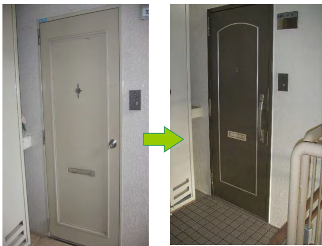
玄関扉の更新
