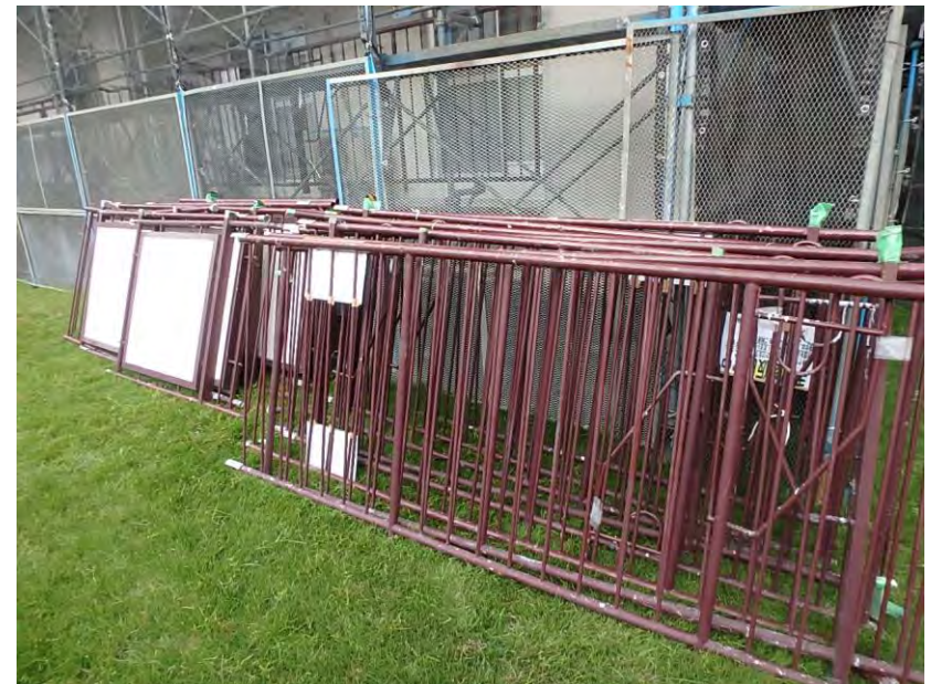
鋼製手すり金物撤去部材
