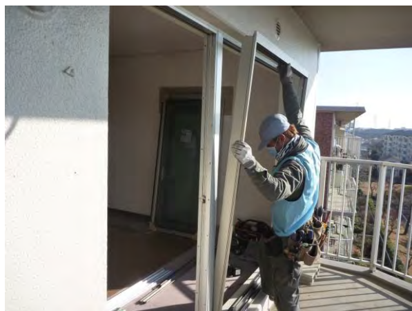
新規枠建て込み
