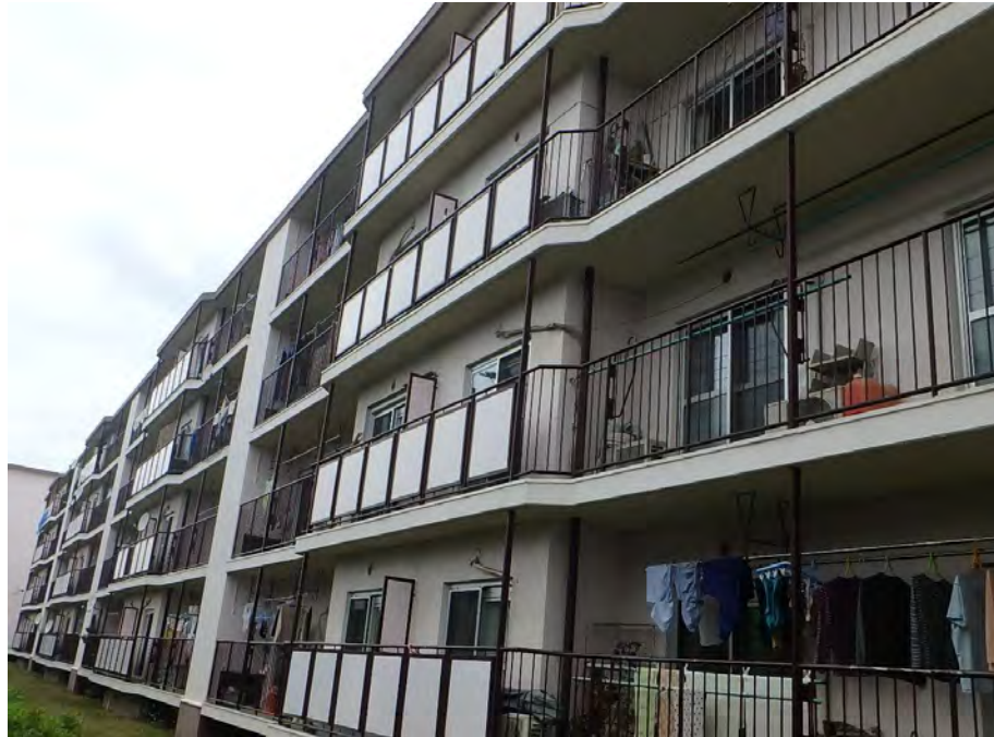
従前の鋼製手すり金物（全体外観）
