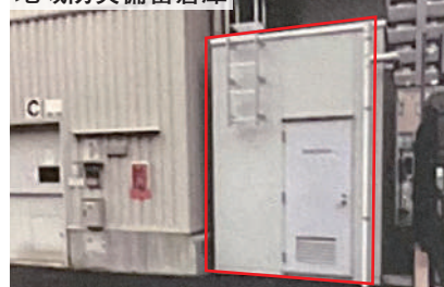
地域防災備蓄倉庫
