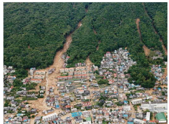
●平成26年8月豪雨による土砂災害 （広島市八木三丁目付近）*3
