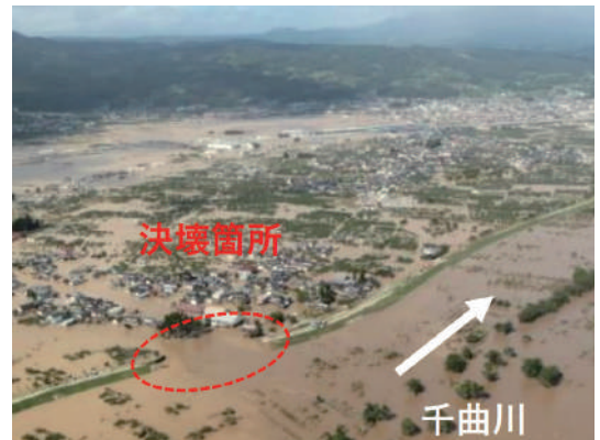
●令和元年東日本台風の被害 （長野市豊野地区）*2
