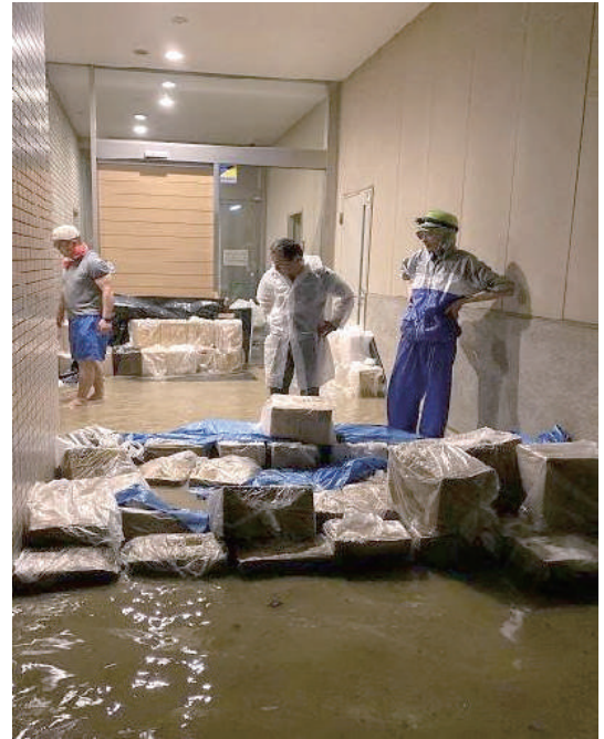
●エントランス付近の開口部 （手造りの土嚢で浸水を阻止） *1
