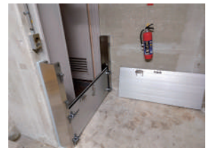
1階設備室の入口に着脱式止水版を設置（事例4）
