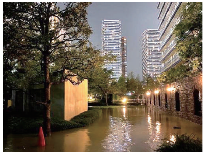
●冠水したマンションの敷地 *4
