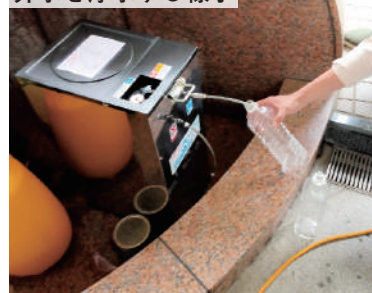
井水を浄水する様子
