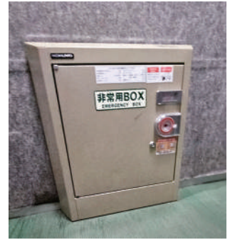
担架が入ることを想定し、省スペース化された防災キャビネット（事例1）
