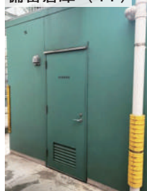
備蓄倉庫（1F）
