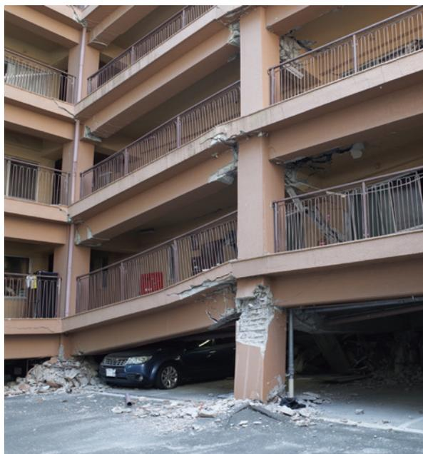
熊本地震被害 壁のせん断破壊
