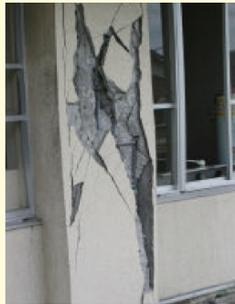
開口部下部の腰壁の影響による被害出典：鉄筋コンクリート造建築物（国土交通省 国土技術政策総合研究所）
