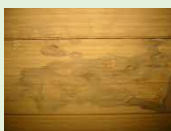
屋上の防水層劣化 による雨漏れ被害
