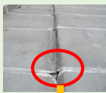
屋上の防水層劣化 による雨漏れ被害
