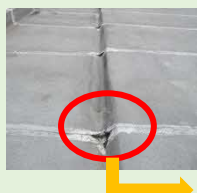
屋上の防水層劣化 による雨漏れ被害
